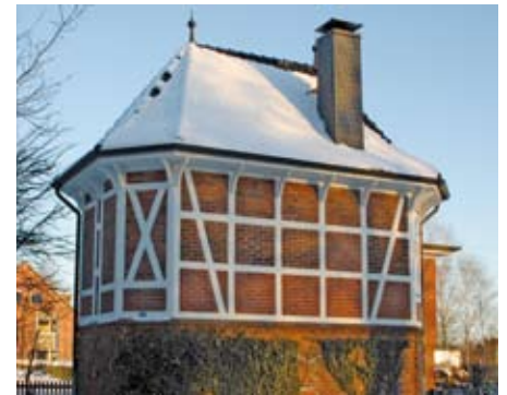
Südlich des renovierten alten Stellwerkes wird eine Lärm-schutzwand bis zur Unterführung gebaut. Sie ist nicht nur für das Seniorendorf unerlässlich, sondern reduziert den Bahnlärm auch in Teilen der Innenstadt.
