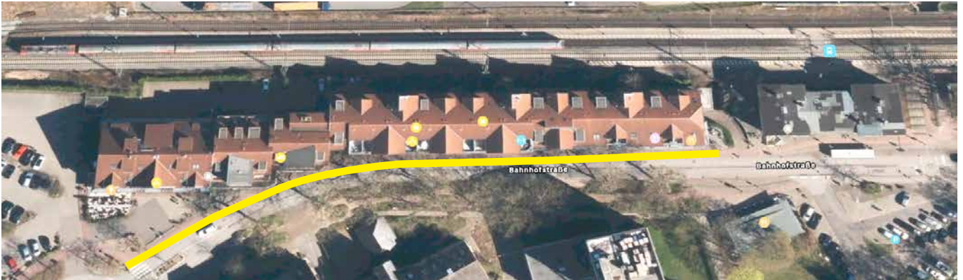
Der Radweg vom Bahnhof bis zum Kreisverkehr ist einer der am stärksten befahrenen in Bargteheide. Er wurde falsch gebaut und inzwischen formal aufgehoben, sodass die Radfahrer
