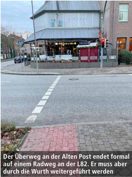
Hier kommt alles zusammen: ein eher schmaler Radstreifen in Randlage, zu stark abgewinkelt, mit einem Laternenpfahl mitten im Weg
