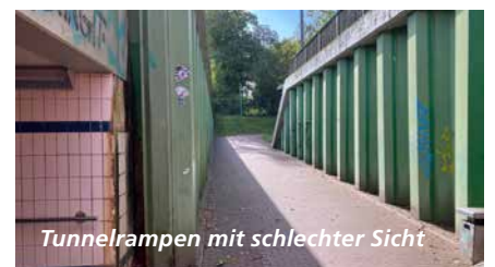
Einfahrt Traberstieg vom Bahnhof
